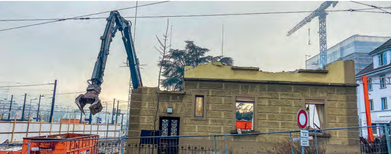
Hausabbruch am Seetalplatz in Emmen.
