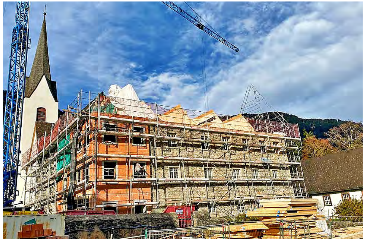
Während drei Jahren eine Baustelle: das Haupthaus der Propstei St. Gerold in Vorarlberg.
